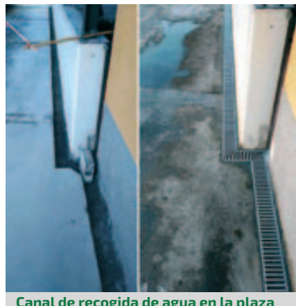
Canal de recogida de agua en la plaza de la calle Balmes
