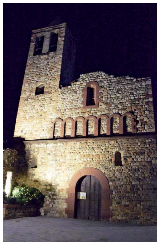
Nova il·luminació de la façana de l'església
