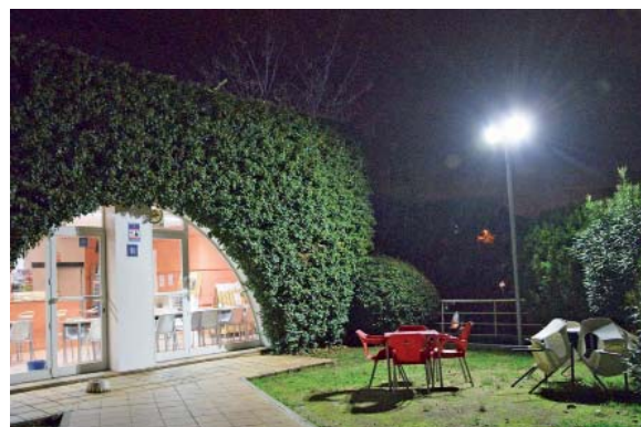
Canvi d'il·luminació a la terrassa-bar del camp de futbol amb lluminària tipus LED
